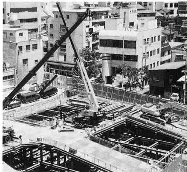
第二次掘削後の構台架設の様子 94. 5. 28撮影
