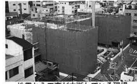
地震から工事が中断している現場
