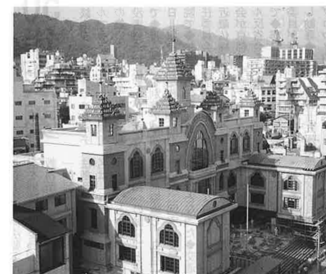
完成間近の建物全景 95. 8. 31 撮影
