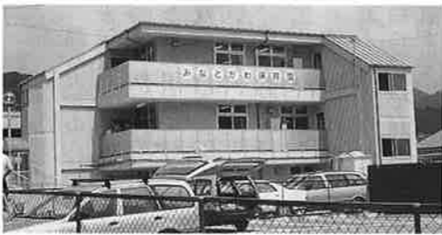
竣工したみなとがわ保育園
