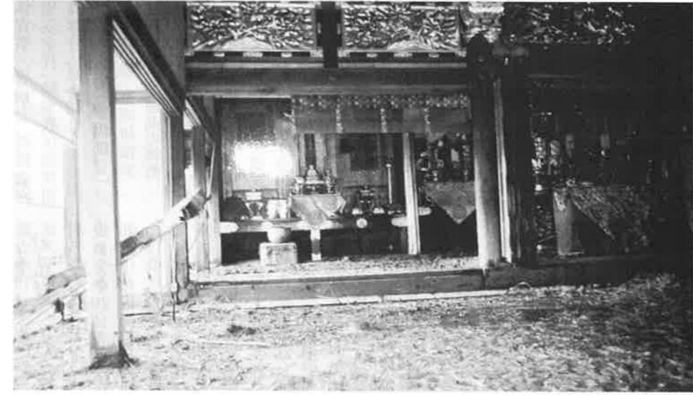
外陣まで土砂がうめつくした長専寺本堂
