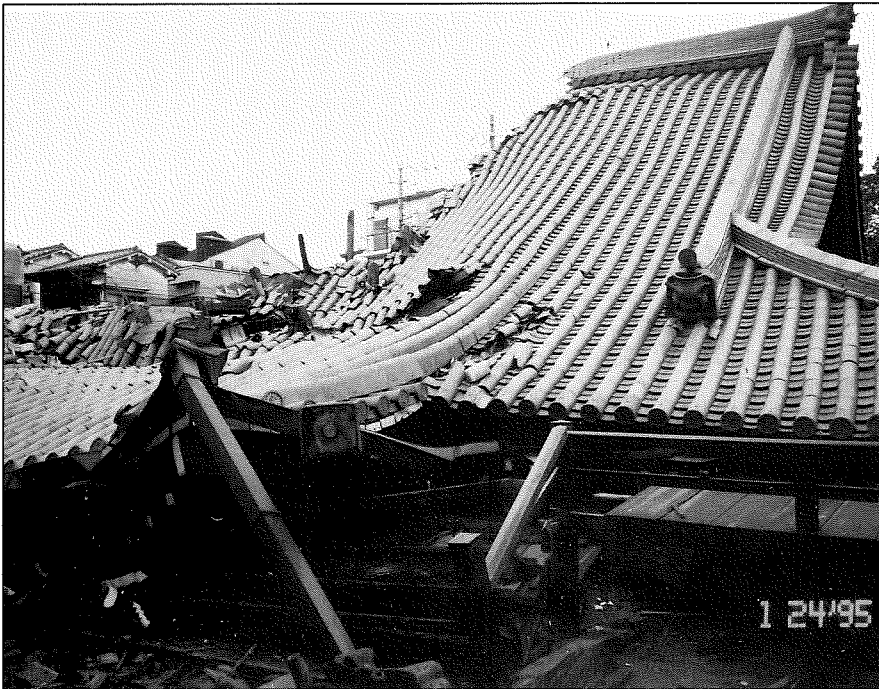
本堂屋根の一部を残しすべて倒壊した神戸東組覚浄寺
