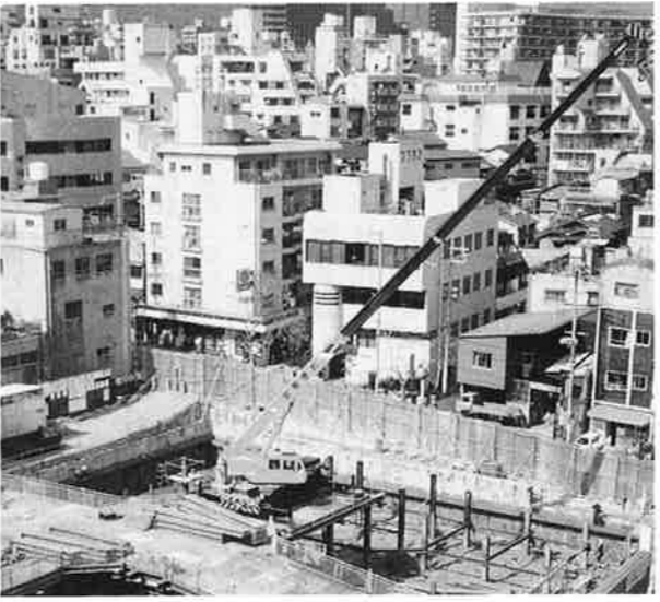
掘削して構台架設の様子 94. 4. 28撮影
