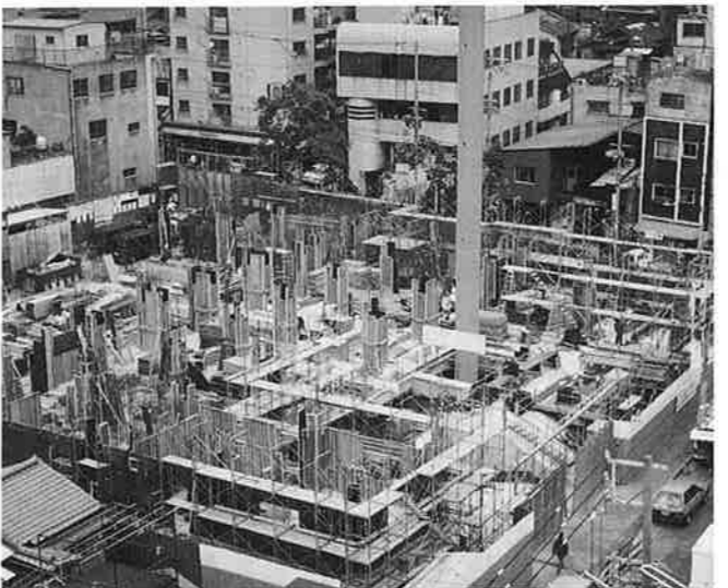
1階の柱の型枠を組む現場94, 10, 27撮影
