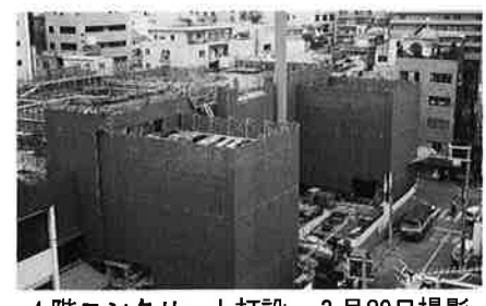
4階コンクリート打設 3月29日撮影
