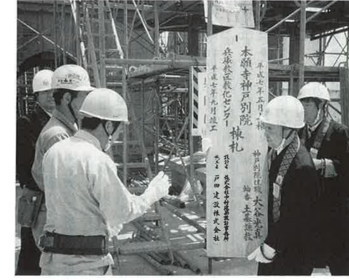
5月24日 上棟式の後 屋上で棟札を渡す所長
