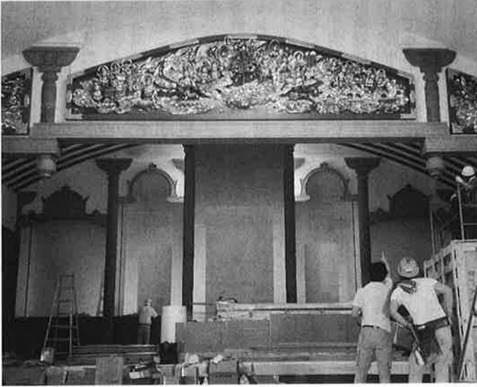
仕上げ工事にかかっている本堂内陣 7月28日撮影
