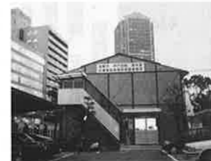
建設工事期間中仮設事務所
