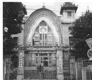
解体直前の別院正面
