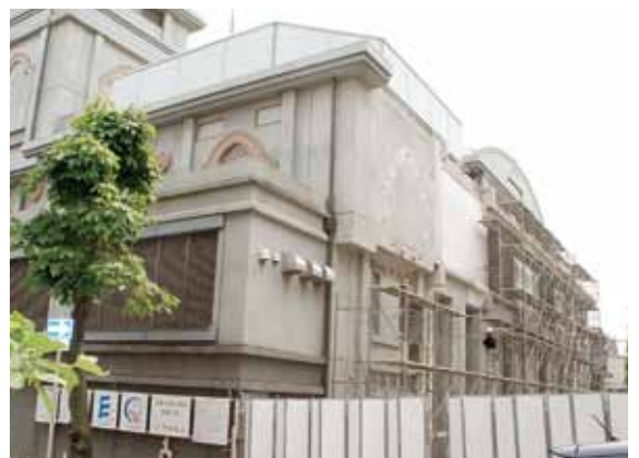
工事が進む北側境内地
