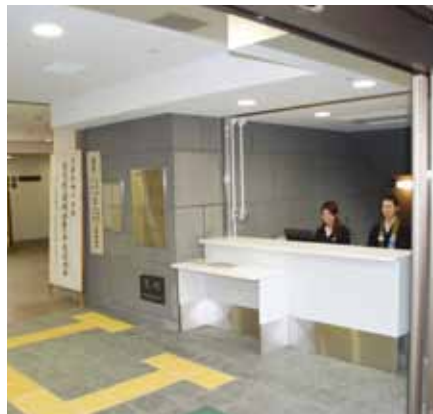
車イス用のカウンターや点字ブロックも整備
